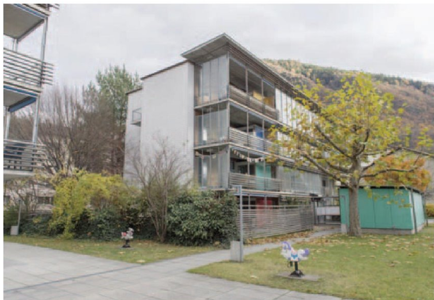
Après leur assainissement, les sols entre Viège et Niedergesteln pourront de nouveau être utilisés par les enfants sans restriction. SACHA BITTEL/A
