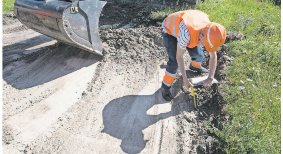
An die Arbeit. Das Sanierungskonzept ist genehmigt.
