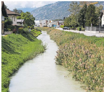
Turtig. Auf dem rechten Ufer des Grossgrundkanals beginnen demnächst die ersten Sanierungsarbeiten. FOTO KEYSTONE
