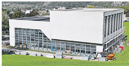
Sportzentrum. Die Arbeiten auf dem Dach und an der Fassade sowie im Schultrakt schreiten voran. FOTO WB
