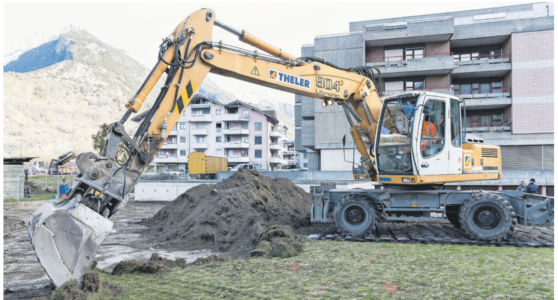
Umfangreiche Arbeiten. Im Rarner Dorfteil Turtig hat die Sanierung der durch Quecksilber belasteten Parzellen begonnen.
