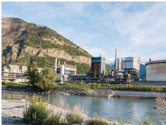
La Lonza, une nouvelle fois sous les feux de la rampe. LOUIS DASSSELBORNE
