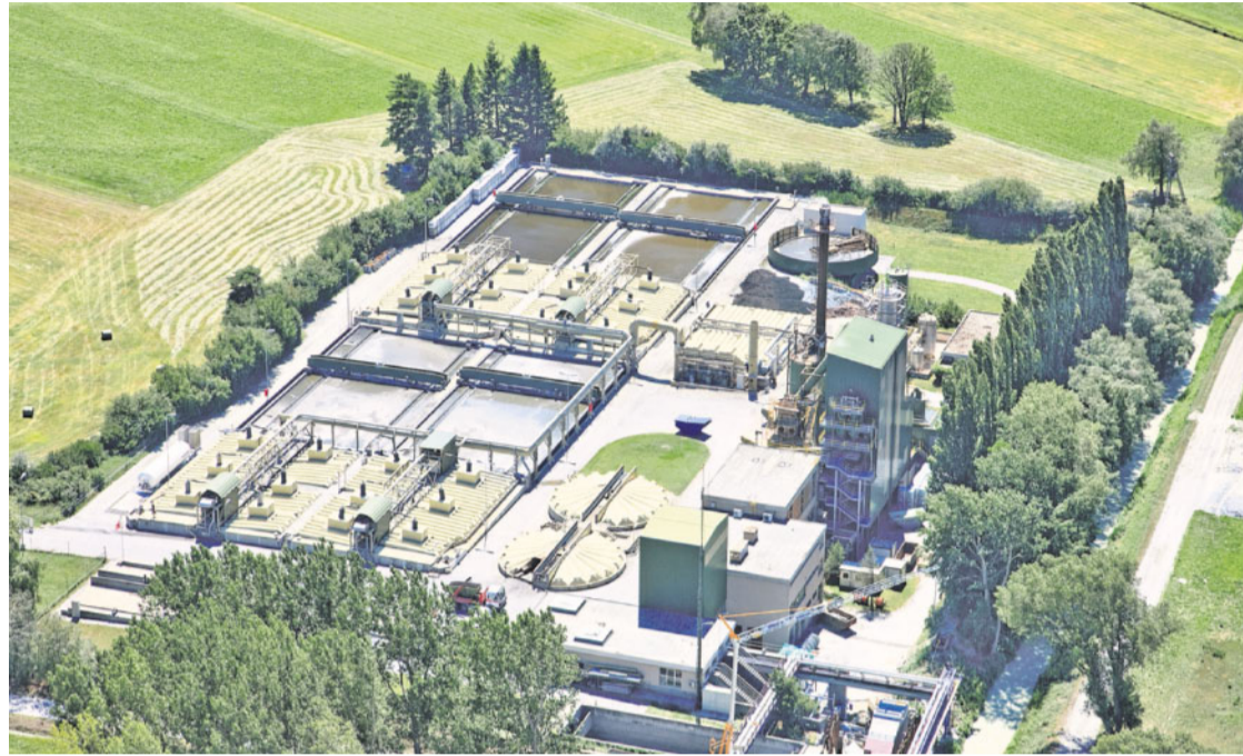
Am stärksten verschmutzt. Die höchsten Dioxan-Kontaminationen fanden sich bisher im Grundwasser rund um die ARA Visp.
