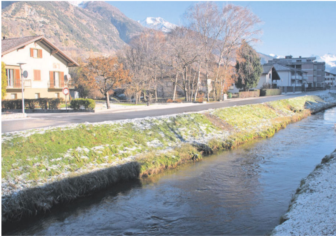
Betroffen. Geht alles glatt, könnte mit der Sanierung der belasteten Parzellen in Raron (Bild), Visp West und in den Kleegärten bereits diesen Herbst begonnen werden.
